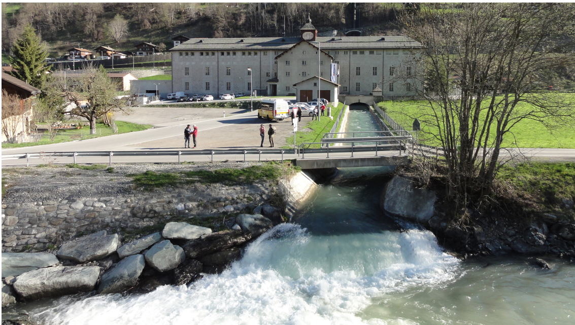
Unterwasserkanal des Kraftwerks Küblis
