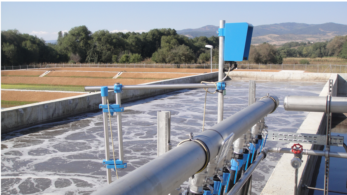
Generalplanung für Bau einer Kläranlage für 15'000 Einwohnerwerte in Berovo, Mazedonien
