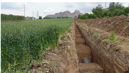
Sanierung Trink- und Abwasserinfrastruktur in Osch und Jalal-Abad, Abwasserleitung in Osch, Kirgisien
