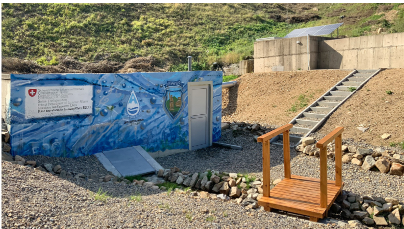
Rehabilitiertes Einlaufbauwerk unterhalb des Loshana-Damms
