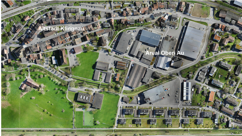
Orthofoto der Altstadt Klingnaus und des Areals Oberi Au
