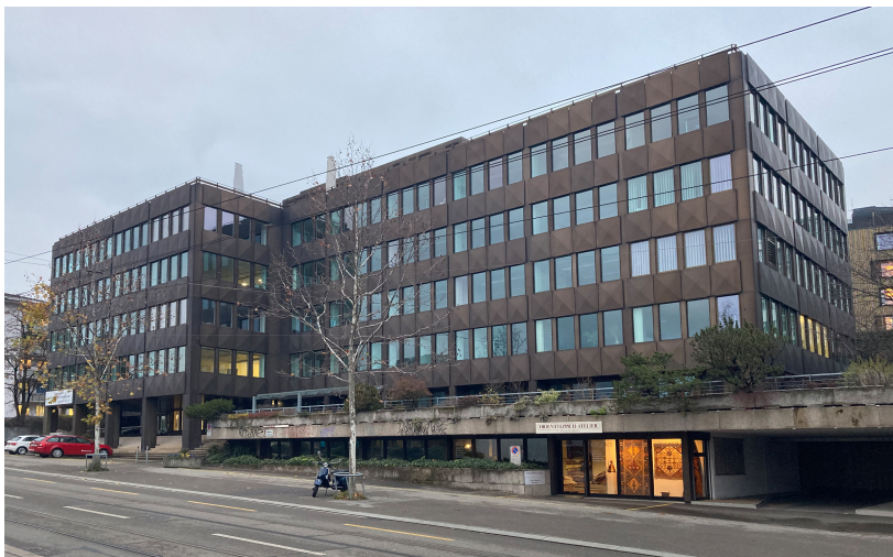
Bürogebäude WEV, Weinbergstrasse, ETH Zentrum
