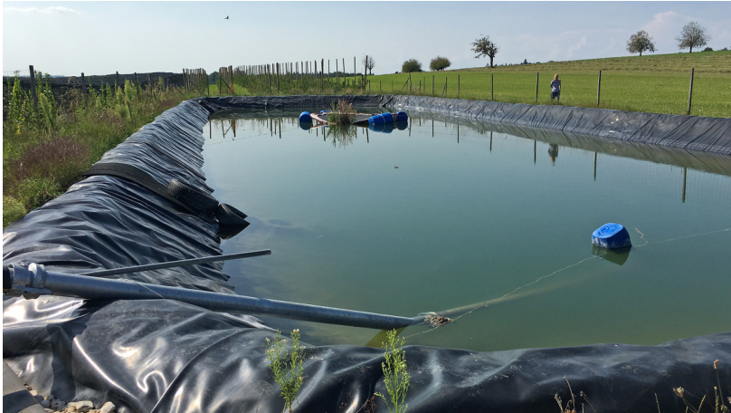
Folienteich mit Entnahmeleitung und Ausstiegshilfe
