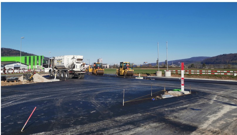
Belageinbau in der Industriestrasse.
