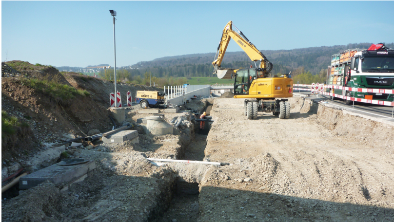
Werkleitungsarbeiten in der Mutschellenstrasse.
