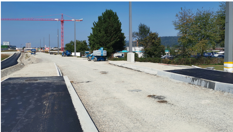
Unterbau Bahntrasse im Niderfeld.
