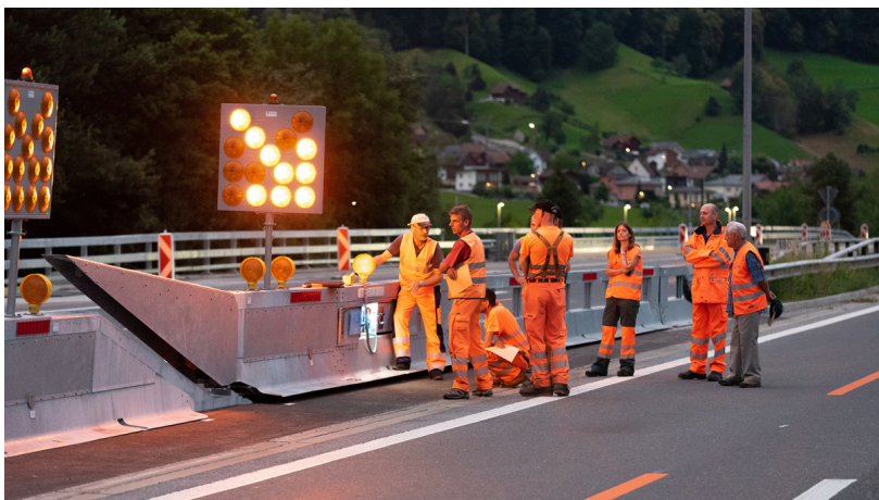
Fotografie der verschiedenen Instandsetzungsmassnahmen
