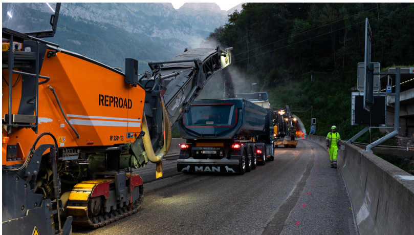
Fotografie der verschiedenen Instandsetzungsmassnahmen
