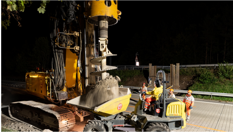
Fotografie der verschiedenen Instandsetzungsmassnahmen
