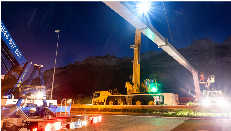
Fotografie der verschiedenen Instandsetzungsmassnahmen
