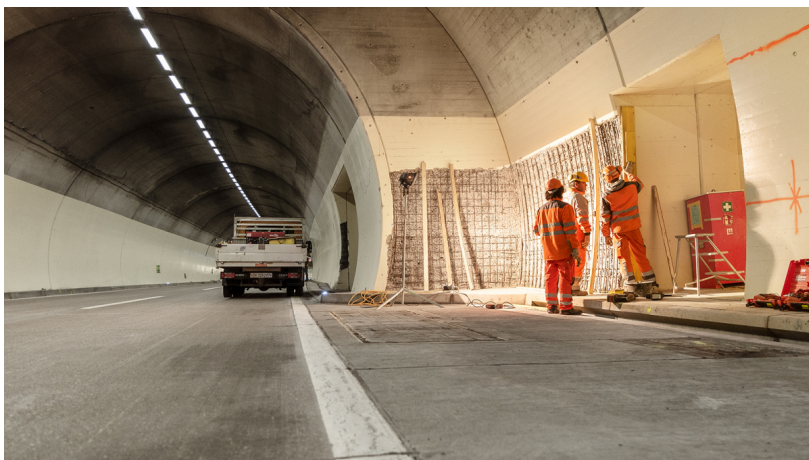
Fotografie der verschiedenen Instandsetzungsmassnahmen
