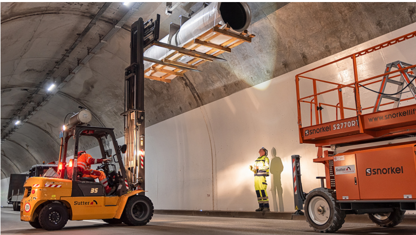
Fotografie der verschiedenen Instandsetzungsmassnahmen
