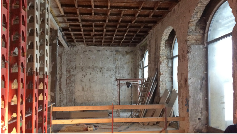
Holzbalkendecken über dem Erdgeschoss (Bildquelle: EBP)
