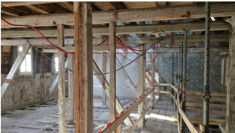
Freigelegter Dachstuhl (Bildquelle: EBP)
