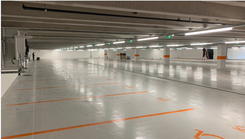
Ansicht Tiefgarage (Bildquelle: EBP)
