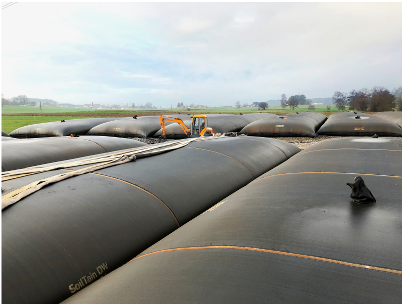
Die gefüllten Geotextil-Säcke auf dem Entwässerungsplatz
