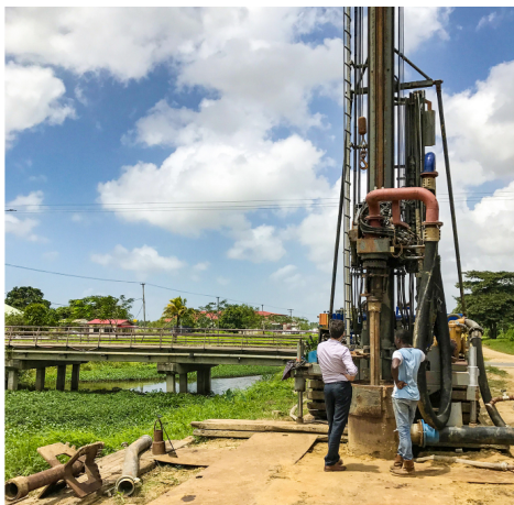
Paramaribo Gebiet, Surinam: Bohrung eines neuen Grundwasserbrunnens
