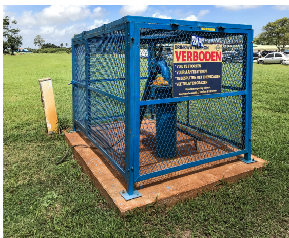
Paramaribo Gebiet, Surinam: Schutz eines Grundwasserbrunnens
