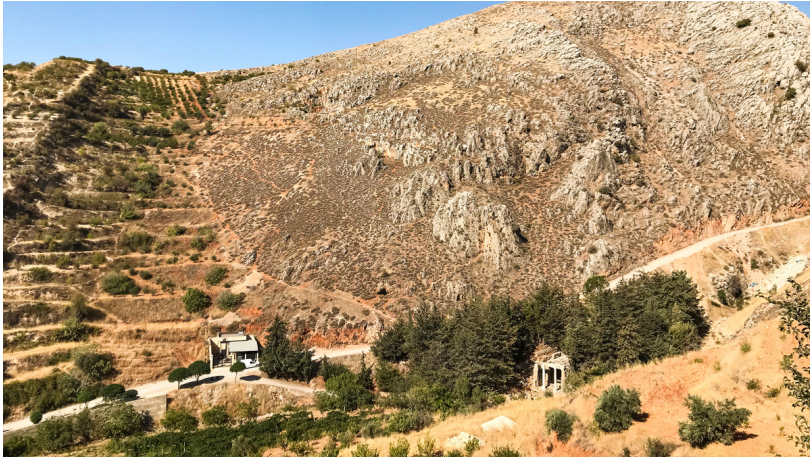
Möglicher Standort für eine Solaranlage in der West Baalbek Region
