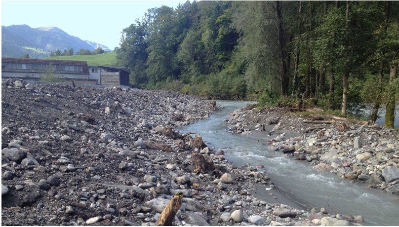
Wechselfeuchte Rinne mit abgeflachtem Ufer und eingebauten Wurzelstöcken.
