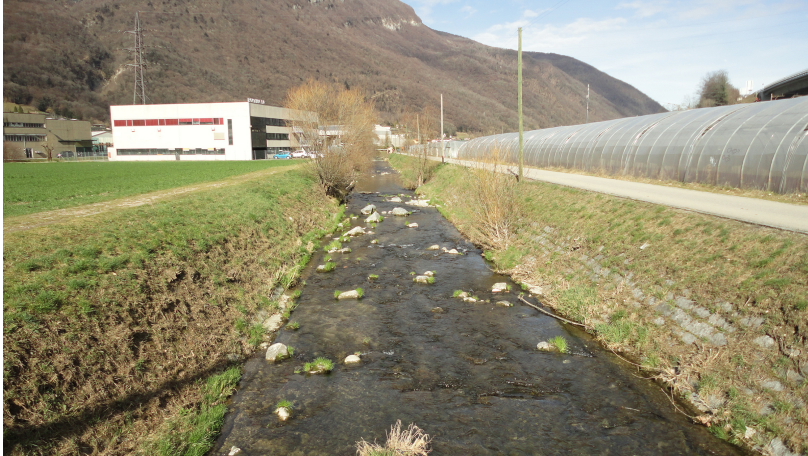
Blick in Flussrichtung der Laveggio auf Höhe der Abwasserreinigungsanlage
