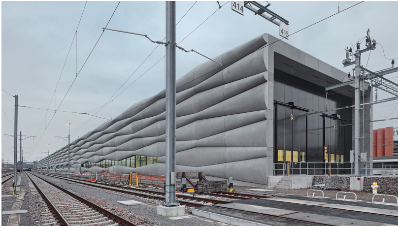
Serviceanlage Herdern aussen
